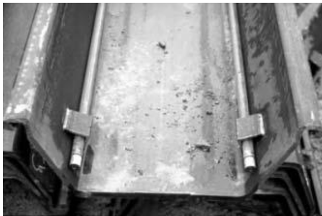
2 pav. Vamzdelių tvirtinimas prie įlaido
